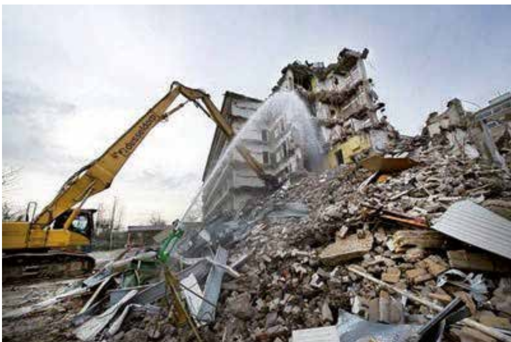
De sloop van verpleeghuis Martinushof aan de Slochterenweg in 2011. © Marina Popova
